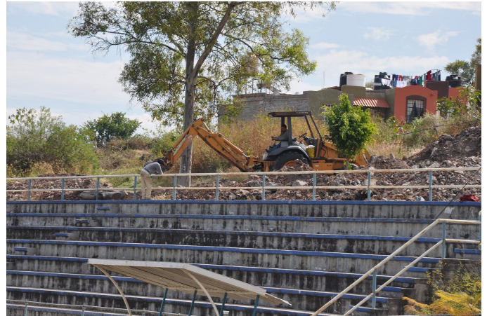
Construcción de techumbre en cancha de fútbol.
