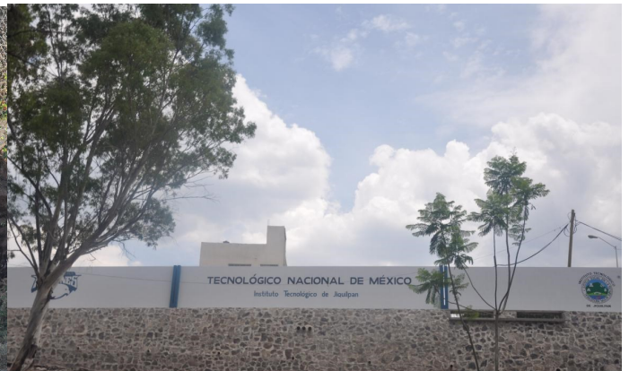
Barda perimetral terminada.
