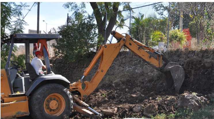
Inicio de trabajos de construcción de barda perimetral.
