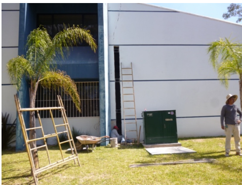
Ilustración 23 Mejoramiento de infraestructura física.
