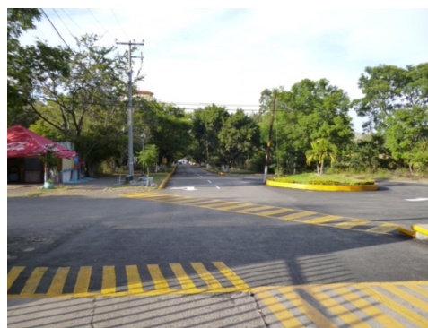
Ilustración 24 Reencarpetamiento de la capa asfáltica del estacionamiento del auditorio.
